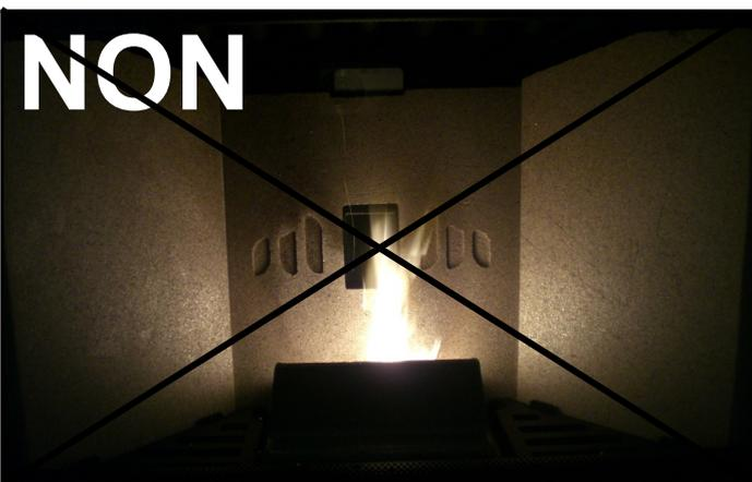
Combustion **PAS OPTIMAL**, la flamme est trop serrée avec une quantité élevée de pastilles incandescentes sortant du brasero.
